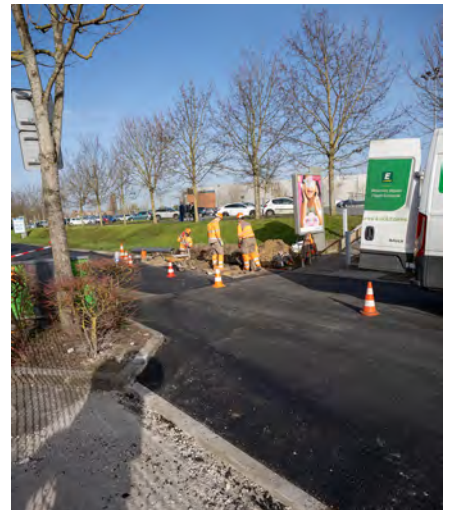
8. Rue de la Reneuse, réfection de la chaussée, avec également la création d'un ralentisseur pour sécuriser le passage piéton et la sortie du parking du centre commercial.
